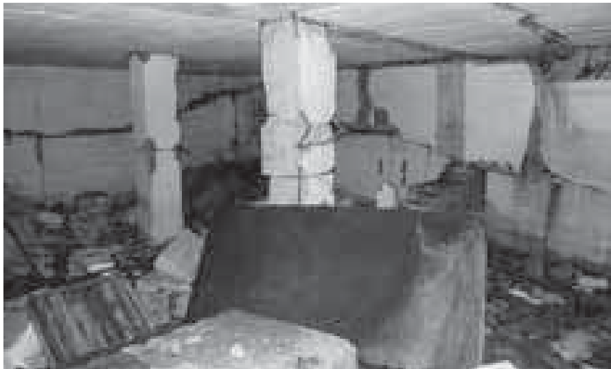
Überreste der Fertigungshalle F1 für die V2, in der sich auch das KZ Karlshagen II befand, September 2013. Jikeli
